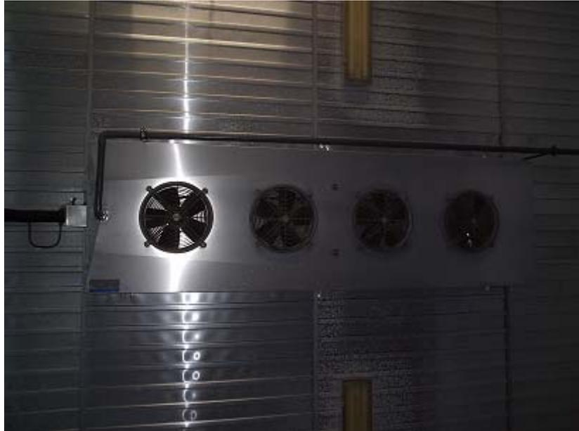
*Fig 7.2. Evaporador de la sala de despiece*
