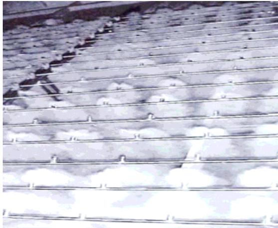
Fig 10. Parrilla de inyectores de un sistema de Fog.
