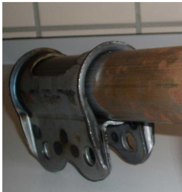
Fig. 1.2-2. Ajuste a presión de abrazadera y tubo.
