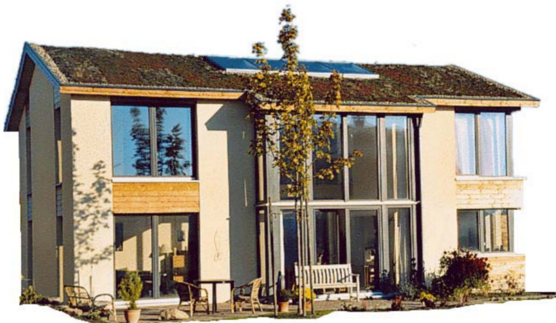
Abbildung 4.5: Südwest-Ansicht des Referenzgebäudes
