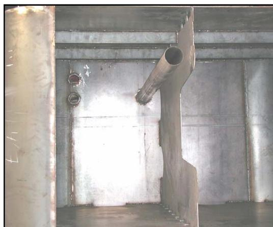
Figura 5. Detalle tubo de llenado
