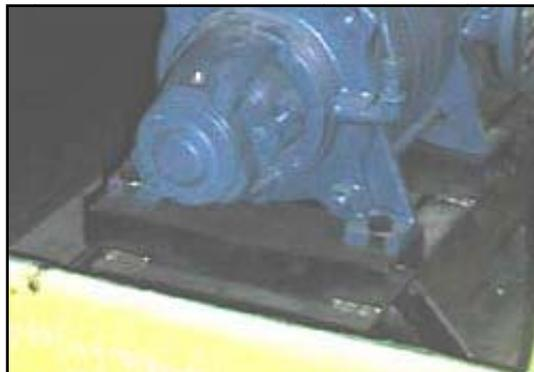
Figura 15. Unión de la bomba a la bancada.
