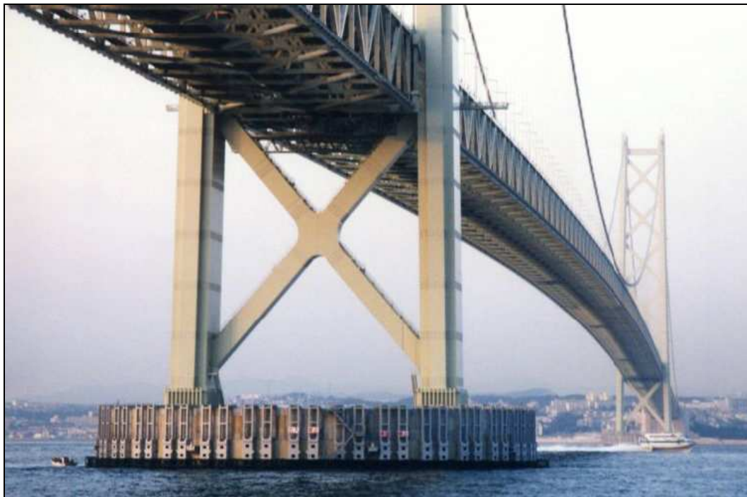
Figura 1.1.1 Puente Akashi Kaikyō (Japón), con el vano más largo del mundo.
