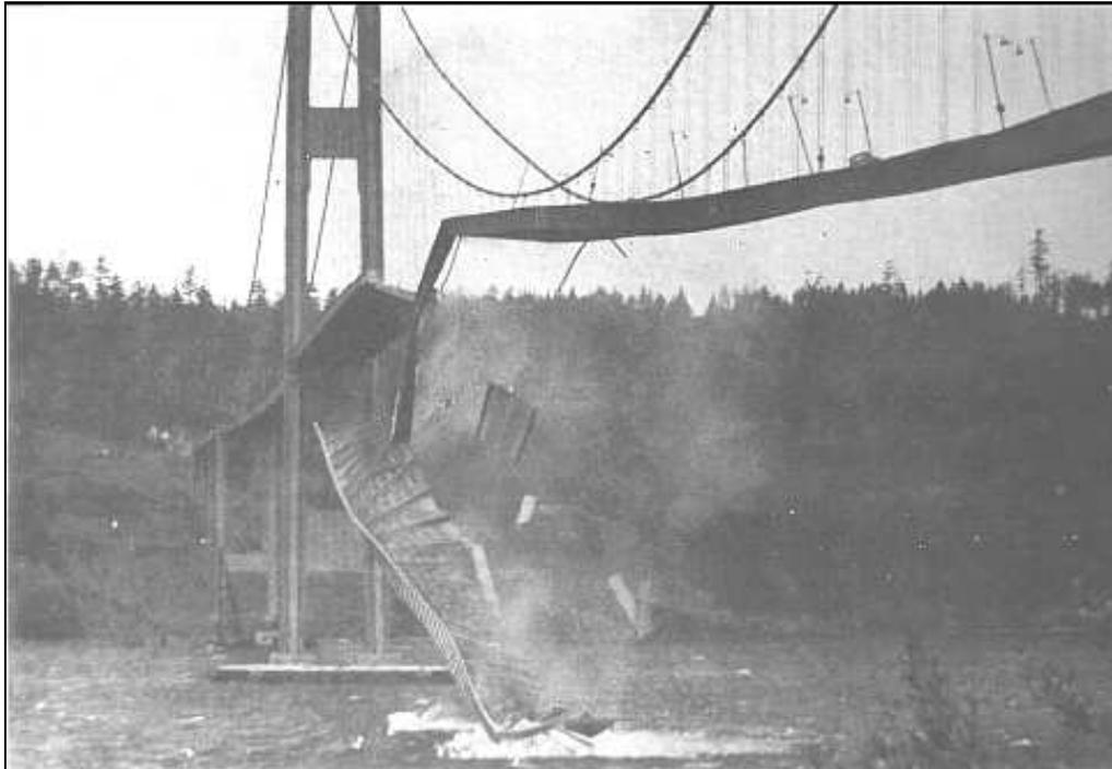
Figura 2.1.3 A pocos minutos después la primera pieza de hormigón calló. Se puede observar cómo las vigas que forman el tablero han sufrido una deformación de alabeo.
