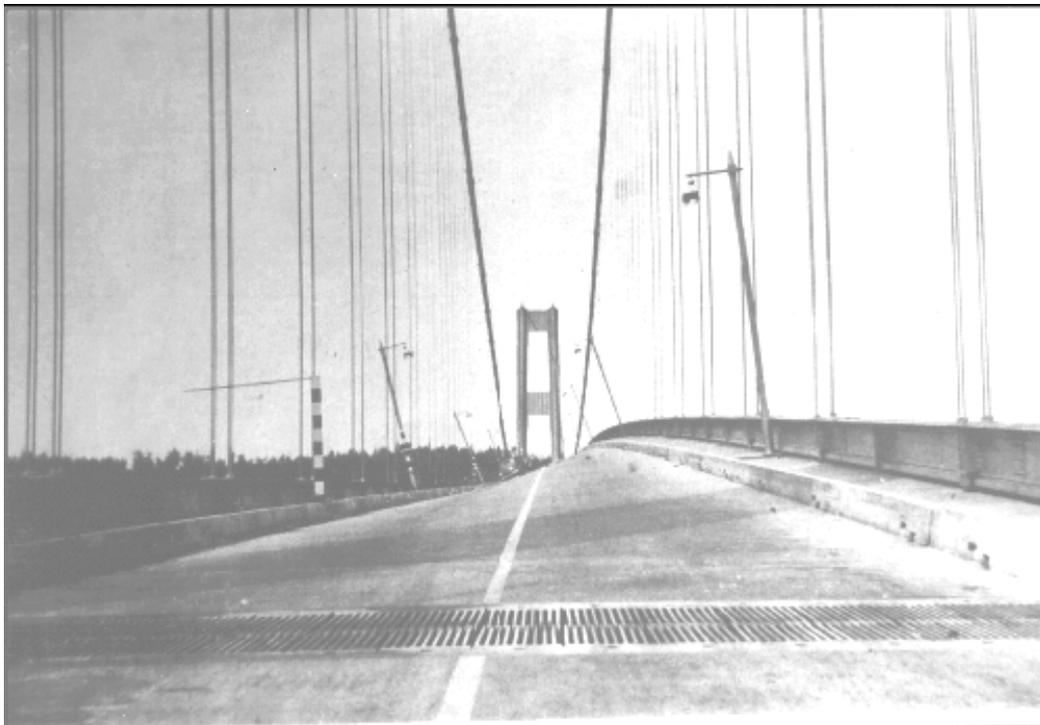
Figura 2.1.2 Cuando el movimiento de torsión alcanzó el máximo, la acera lateral derecha tuvo una elevación de 28 pies (8.5m) más alto que la acera lateral izquierda.
