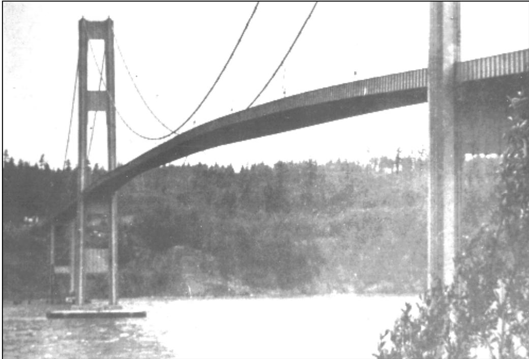
Figura 2.1.1 Esta fotografía fue realizada en los primeros momentos de la entrada en inestabilidad de la estructura.
