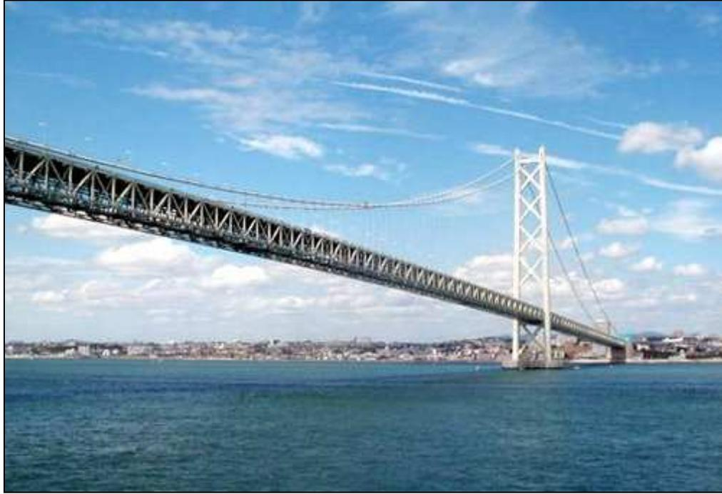
Figura 2.5.14 Fotografía del puente sobre el estrecho de Akashi (Japón), con un vano central de 1991m.
