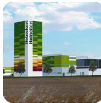
Foto 5 Fábrica de Sevilla
