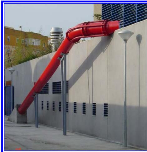
En su parte interior, la tubería de transporte está expuesta a desgaste por abrasión, causado por la basura. Debido a la composición heterogénea de las basuras, los factores de abrasión se han determinado empíricamente. En líneas generales, el factor de abrasión aumenta proporcionalmente al incremento de la velocidad del aire de transporte al cuadrado.
