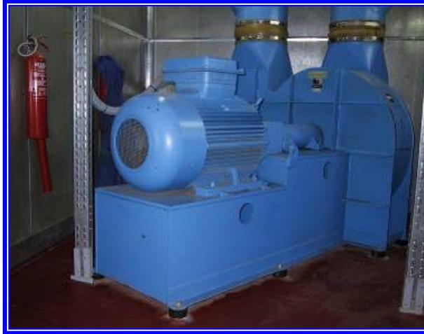
A través de acoplamientos flexibles, los turboextractores están accionados por motores eléctricos.
