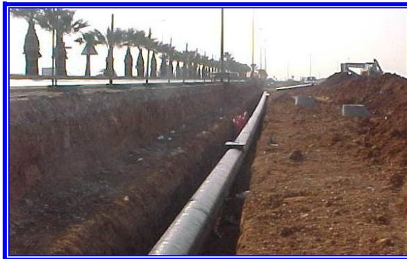
La tubería de transporte va enterrada bajo tierra, a una profundidad de aproximadamente 3,0 metros. Los cables eléctricos y los tubos de aire comprimido, que conectan todas las válvulas del sistema neumático con la central de recogida, están instalados junto con la tubería de transporte.
