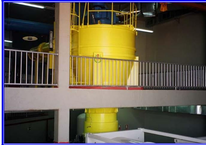
Esta construido en acero, y equipado con indicadores de nivel de basura. A través de una tolva de alimentación, su parte inferior está conectada al compactador de basura mediante un acoplamiento resistente a la depresión.
