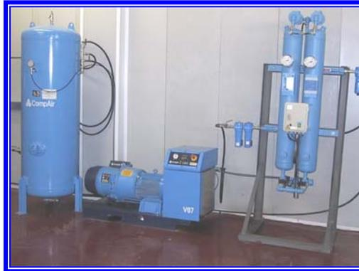
Antes de su distribución a las válvulas de basura y de aire de transporte, el aire comprimido es depurado por los siguientes equipos:
