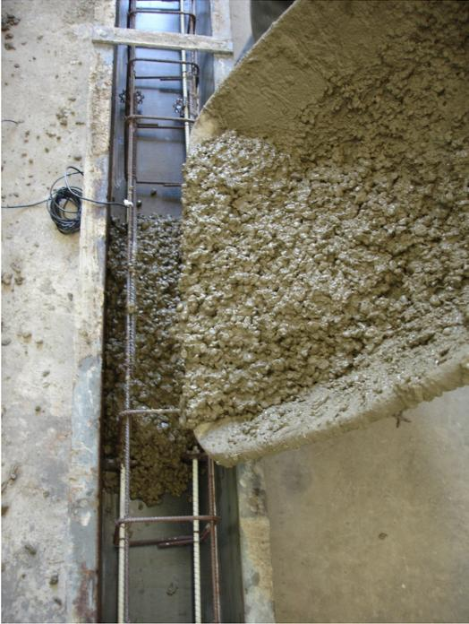
Fig. 3.7: Vertido del hormigón
