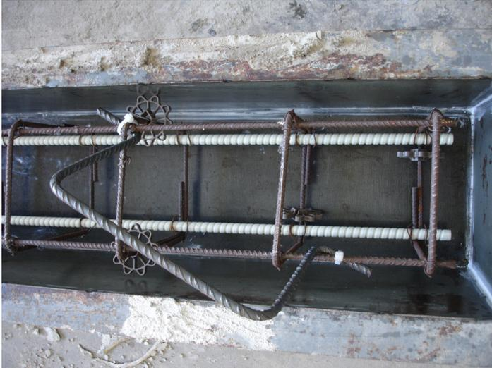
Fig. 3.6: Colocación de las armaduras en los moldes
