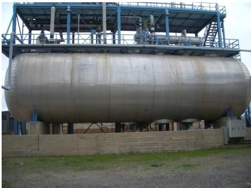
*Figura 2.2.5: Tanque de almacenamiento de sales ensayado en la PSA.*
