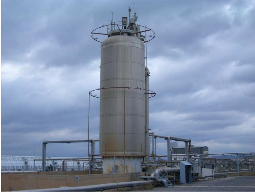
*Figura 2.2.4: Tanque de almacenamiento en aceite ensayado en la PSA.*
