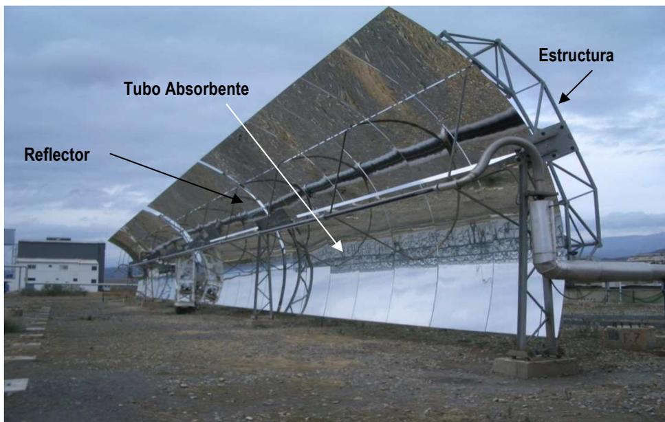
Figura 2.1.3: Partes de un colector cilindro parabólico
