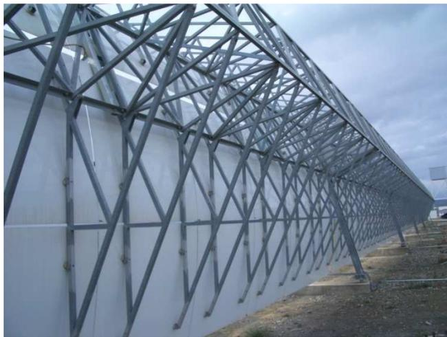
*Figura 2.1.6: Vista de la estructura del colector EURO TROUGH en posición de abatimiento.*
