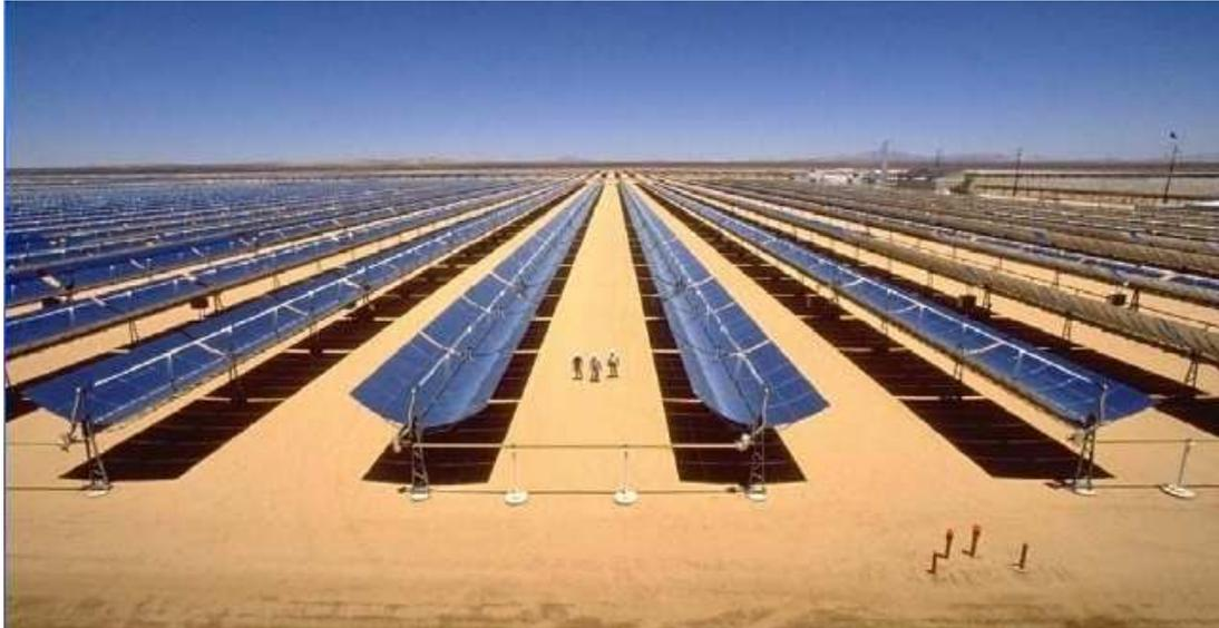
Figura 2.2.2: Vista de un campo típico de colectores cilindro-parabólicos.
