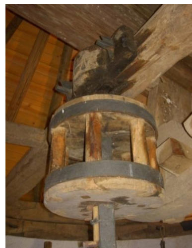
Figura 3.12. Farolillo y palo chamisera donde se ajusta el eje vertical en su parte superior.
