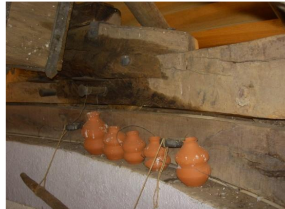
Figura 3.34. Cantarillas usadas para avisar al molinero de los cambios de dirección del viento.
