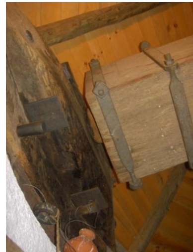
Figura 3.32. Apoyo del extremo posterior del eje.
