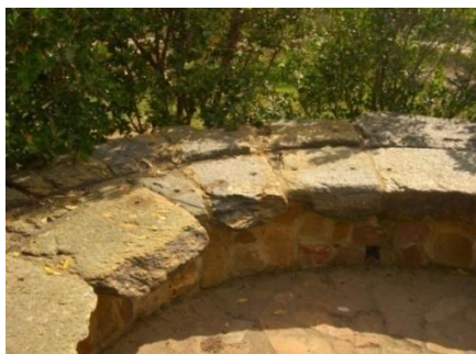
Figura 3.21. Carril original del molino ubicado en la zona exterior del molino.
