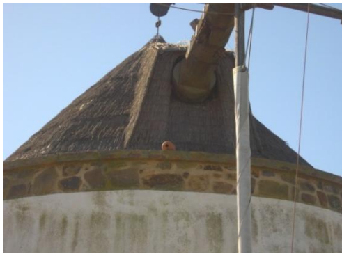
Figura 3.25. Parte delantera del techo cónico, por donde se introduce el eje.
