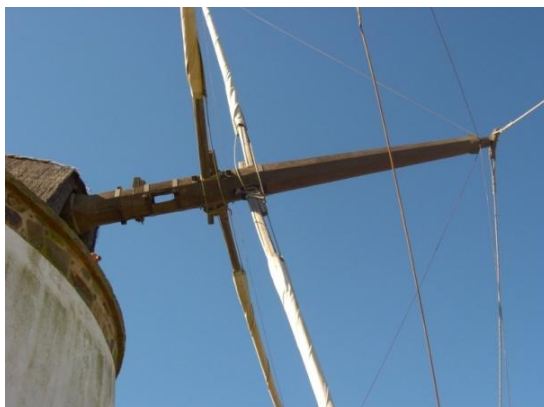
Figura 3.30. Parte exterior del eje, donde se aprecia el encastre de las berlingas de velas.
