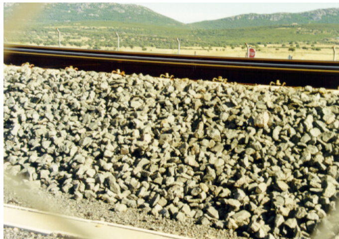
Ilustración 2. 5: Balasto de la vía
