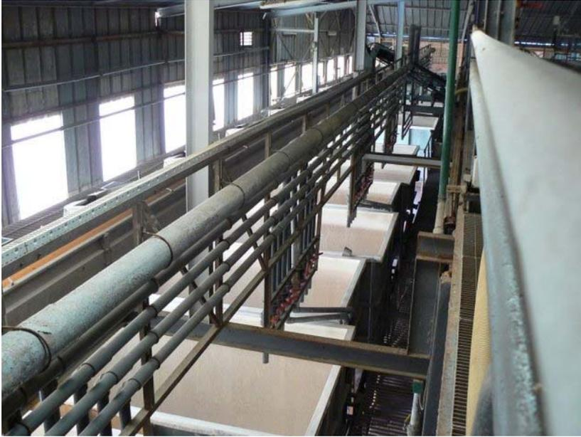
Figura 22. Instalación de tuberías sobre depósitos de oxidación
