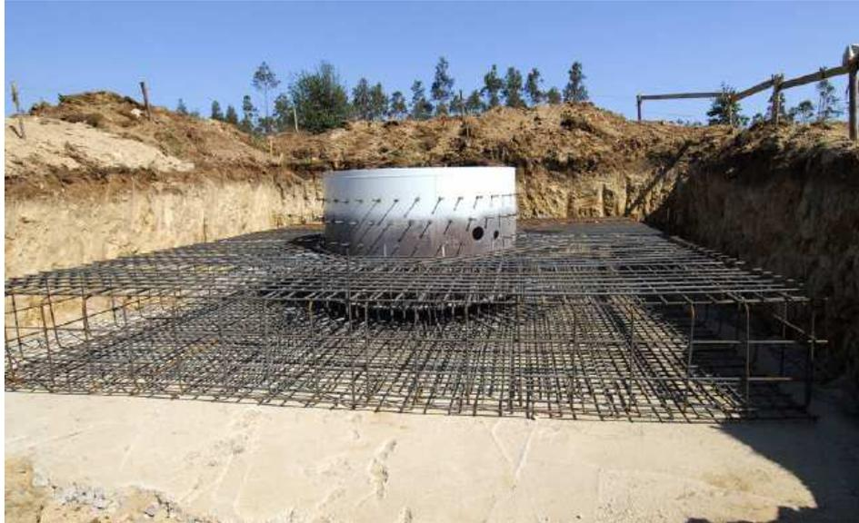
**Figura 5.2:** Cimentación convencional para un aerogenerador de 850 kW, 55m de altura y 52 de diámetro de rotor. Fuente: Endesa Cogeneración y renovables
