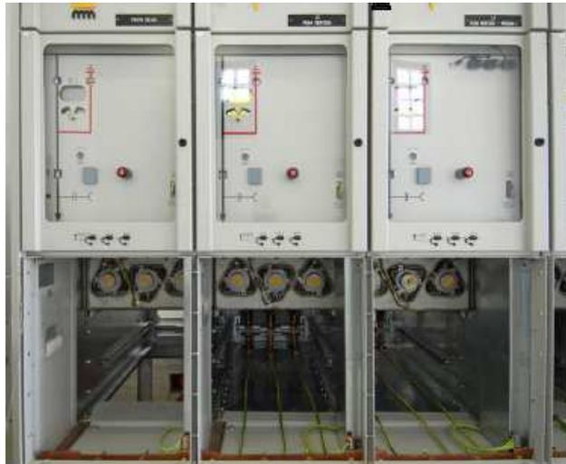
**Figura 5.4:** Celdas de MT durante la fase de montaje de la subestación. Fuente: Endesa Cogeneración y renovables.
