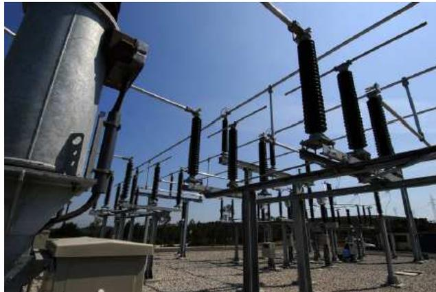
Figura 5.6: Aparellaje subestación intemperie. Fuente: Endesa
