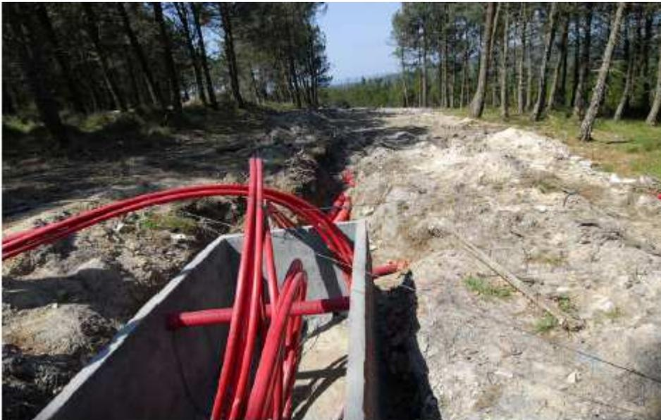
**Figura 5.3:** Ejecución de una arqueta de empalme en la red de MT
