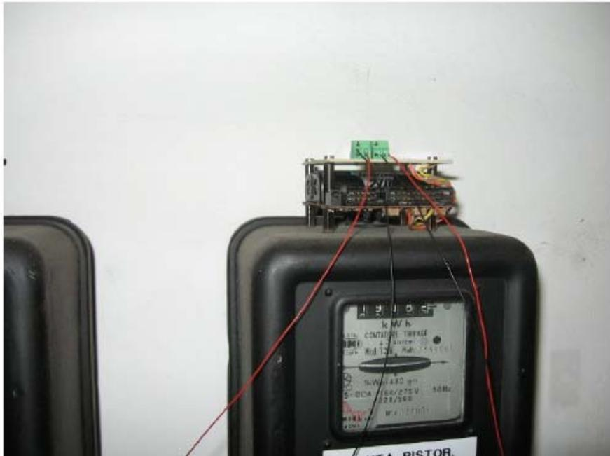
Los contadores presentes en el área son los Vermer modelo Energy-400, que poseen una salida opto acoplada que proporciona un impulso por cada KWH consumido por el cliente conectado al contador eléctrico.
