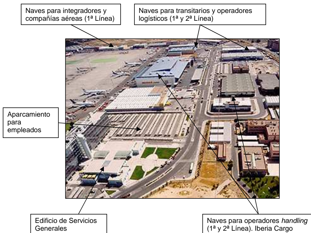
Figura 4.5. Instalaciones del Centro de Carga de Barajas.
