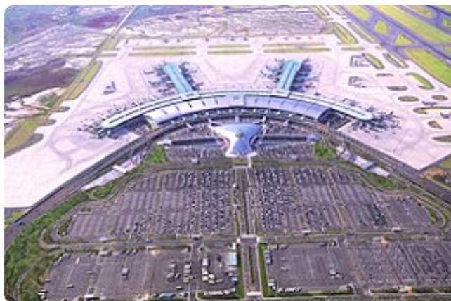
Fig.4. 44. Vista Aérea del Aeropuerto de Incheon Fuente: Web
