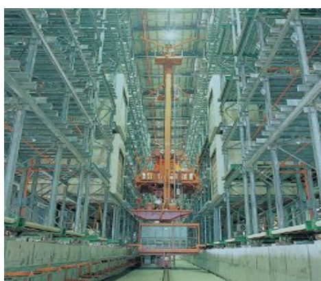
Fig.4. 42. Sistema de Almacenamiento para ULDs en Farglory Free Trade Zone Co. Fuente: Web
