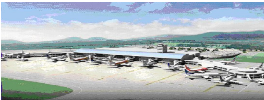
Fig.4. 98. Terminal de Carga. CLA Panamá Fuente: Web
