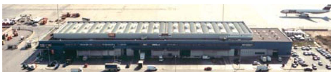
Fig.4. 10. Terminal de Operadores Couriers en el CLA de Barcelona Fuente: Web
