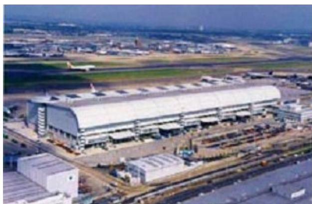
Fig.4. 21. Vista Aérea de WCC de Heathrow Fuente: Web
