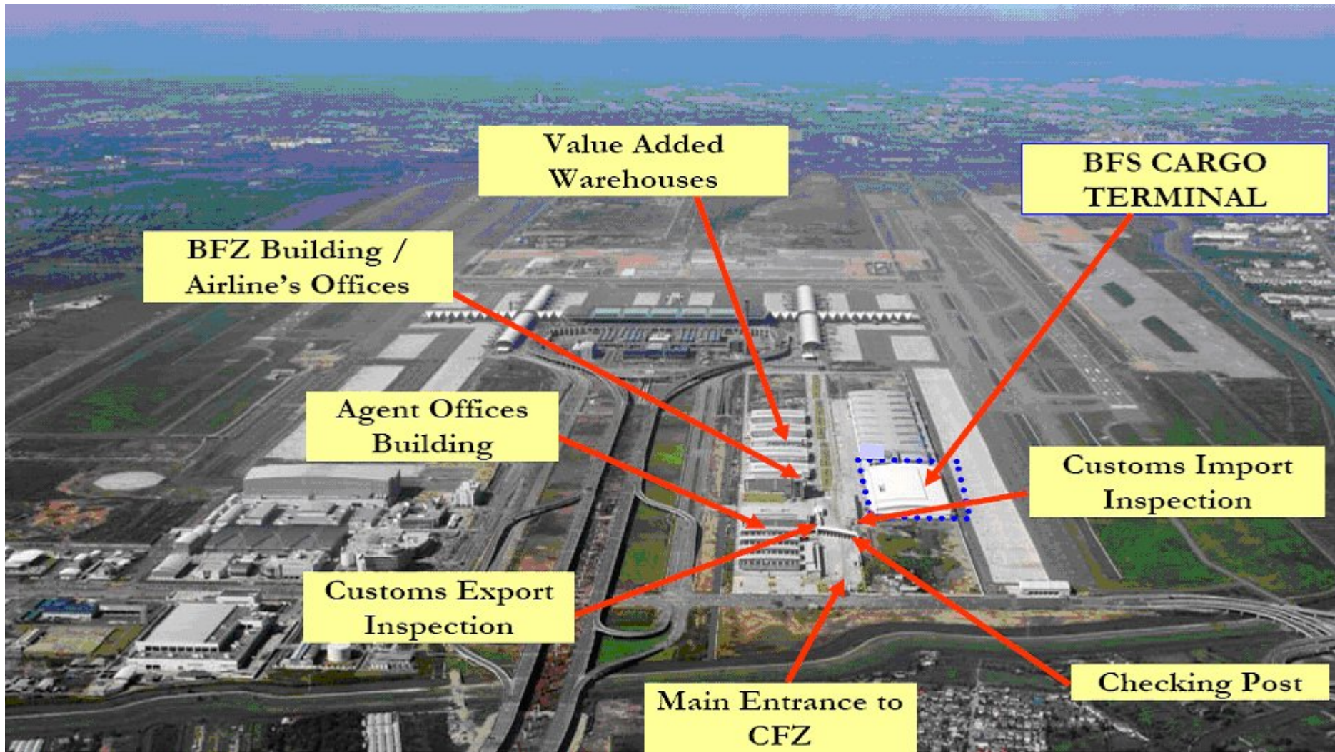
Fig.4. 66. Vista Aérea del CLA del Aeropuerto de Bangkok. Fuente: Web
