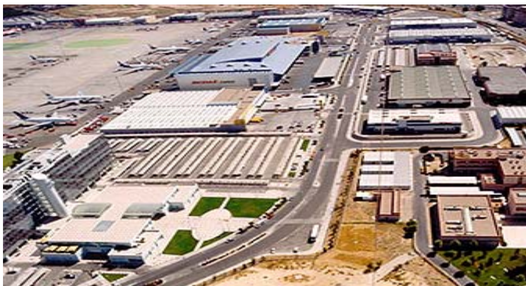
Fig.4. 1. Centro Logístico Aeroportuario del Aeropuerto de Madrid Barajas. Fuente: Web
