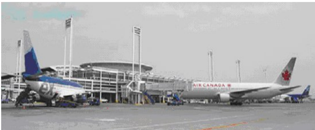
Fig.4. 96. Terminal de Carga. CLA Santiago de Chile Fuente: Web
