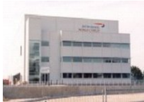
Fig.4. 22. Centro de Perecederos de Heathrow. Fuente: Web
