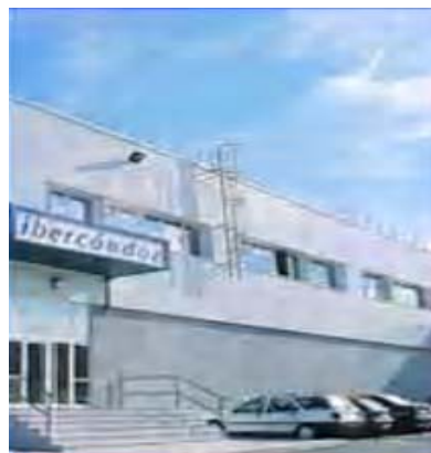
Fig.4. 4. Terminal de Carga de 2ª Línea del CLA de Madrid Fuente: Web
