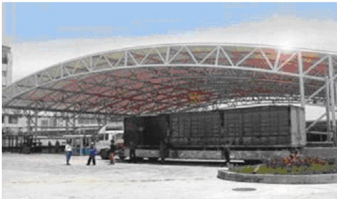
Fig.4. 58. Área de T- Cargo del Aeropuerto de Shangai Fuente: Web
