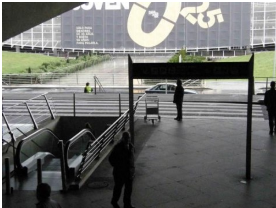
ILUSTRACIÓN 3.1.2.1 XVII. VISTA DEL EDIFICIO APARCAMIENTO P1 DESDE LLEGADAS
