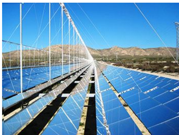
Fig. 3.16. Tecnología lineal de Fresnel.
